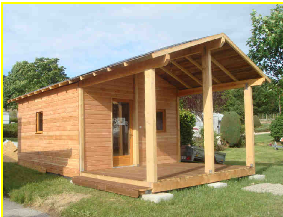
Le nouveau bâtiment d'accueil pour les clients des cabanes perchées
