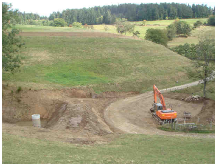
Vue montrant l'épaisseur de la digue et le déversoir d'orage
