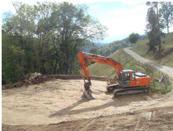
Vue montrant la plate-forme de retournement
