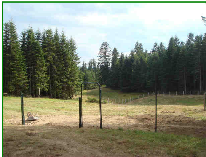
vue prise durant la pose (aujourd'hui achevée) de la clôture
