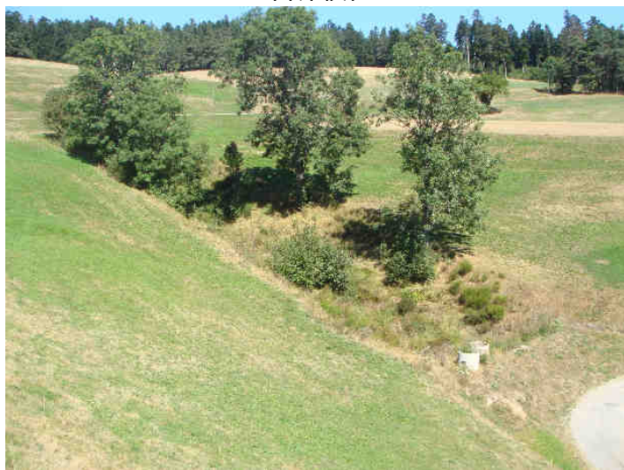
La retenue d'eau du Perrier ...
