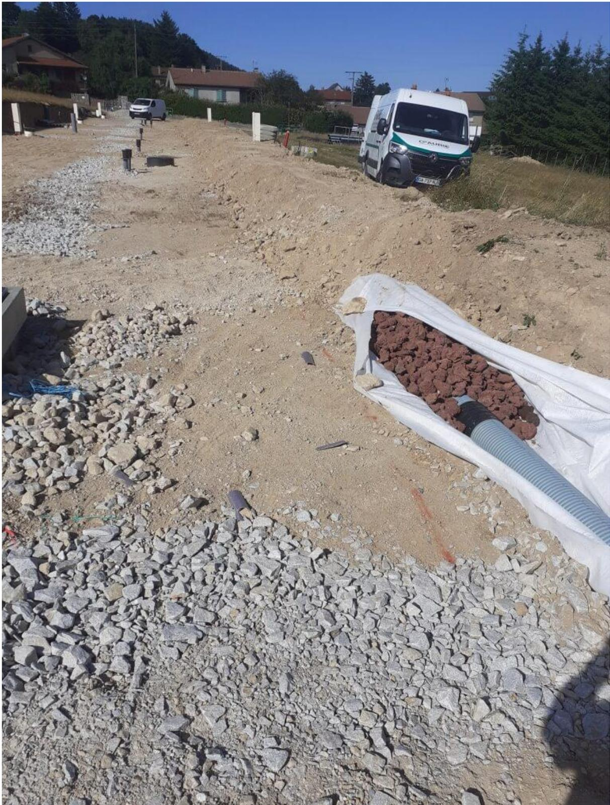
Le trop-plein de l'eau de ruissellement du lotissement est recueilli dans un drain qui court le long de la voie centrale et s'écoule au fond du terrain dans un puits perdu. Le trop plein de ce dernier pourra s'épandre le long d'un tuyau percé qui court sur une ligne de niveau le long de la pente finale.
